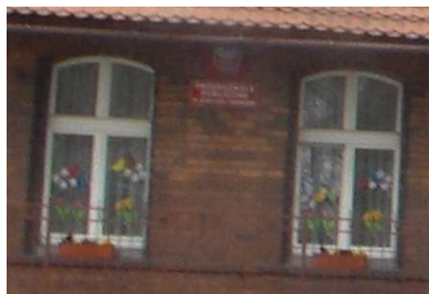
Okna Przedszkola Publicznego (od zewnętrznej strony)
