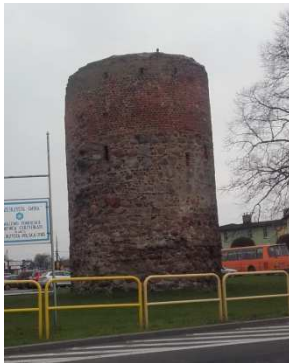
Wieża narożna miejskich murów obronnych z XIII/XIV w.
