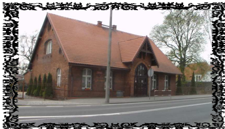
Przedszkole Publiczne - dawna plebania kościoła ewangelickiego
